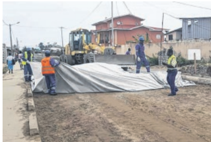
Les travaux ont bien avancé sur l'axe en chantier.
